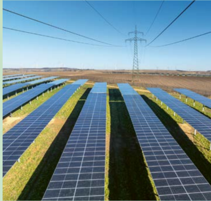
Agri-PV-Anlagen wie hier im österreichischen Gaweinstal ermöglichen die Doppelnutzung für Stromerzeugung und Landwirtschaft.
